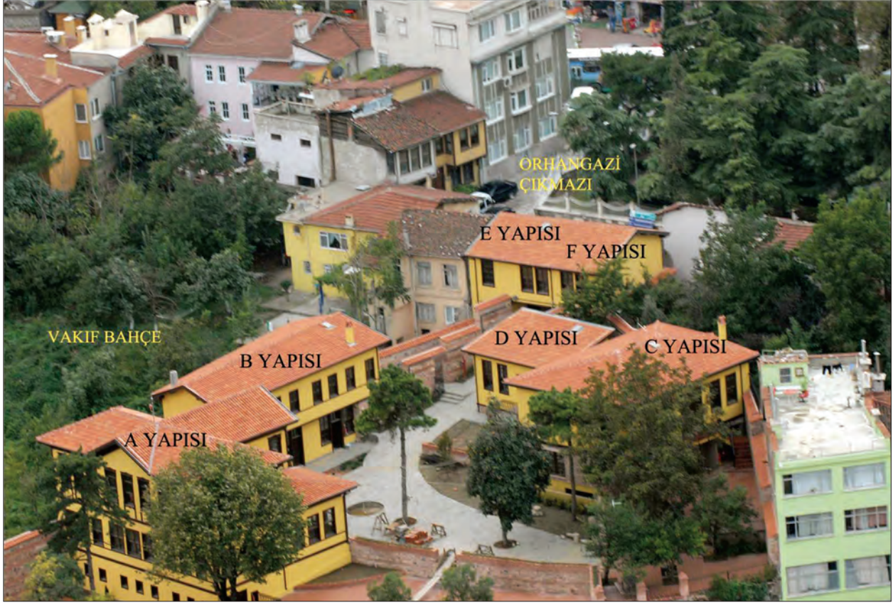
Res. 4. Sümbüllü Bahçe Konağı ve ekleri (P.Kapar, 2006)
