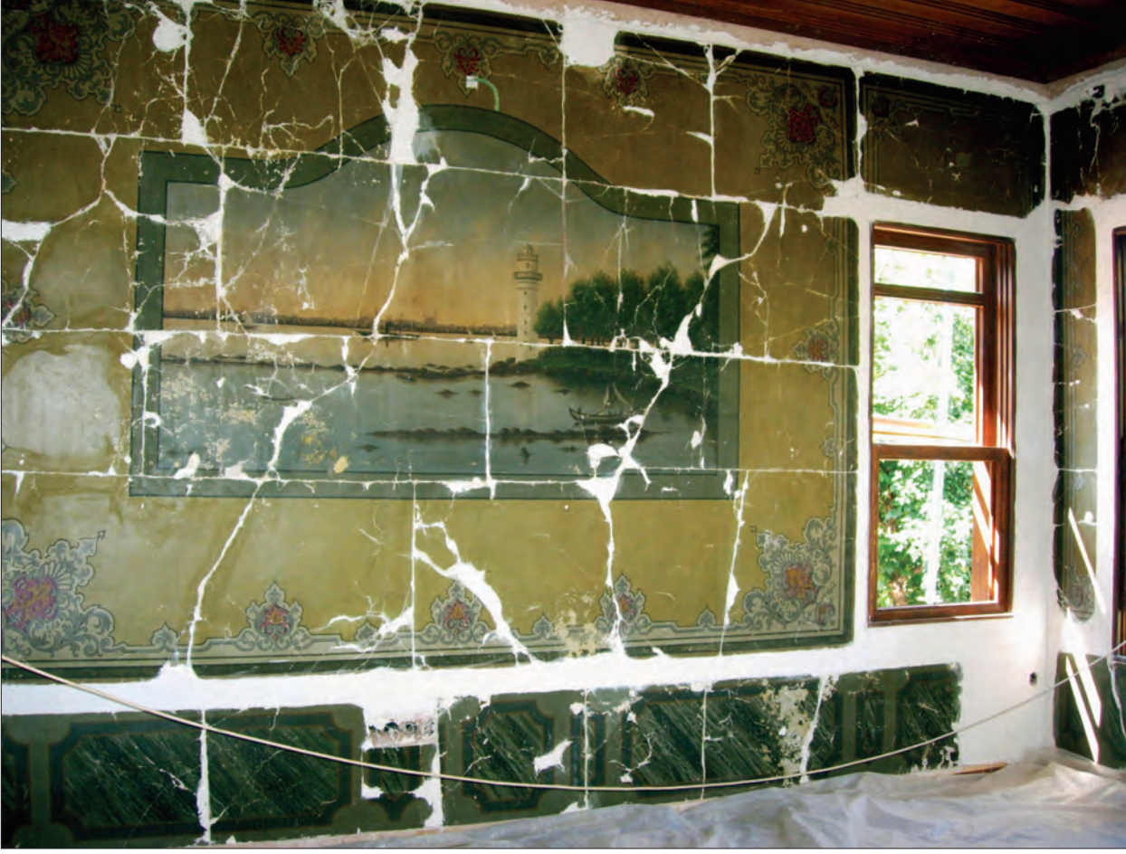
Res. 24a. A yapısı baş odada rekonstrüksiyon sonrasında yerine monte edilen kalemîşi panolar
